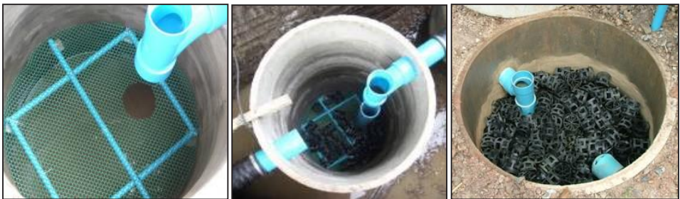
รูปที่ ๓.๑๓ การติดตั้งชั้นตัวกลางภายในบ่อกองไว้อากาศ
