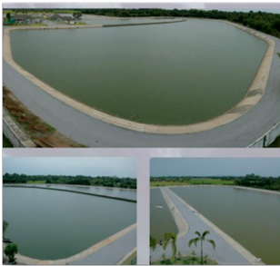
ระบบบ่อปรับเสถียร (SP)
