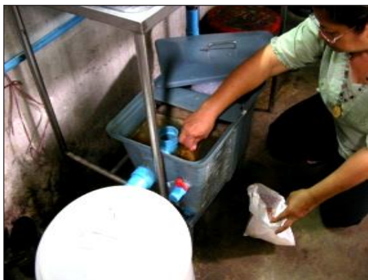
รูปที่ ๓.๑๑ การตักไขมันออกจากถังดักไขมัน
