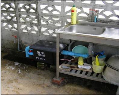
รูปที่ ๓.๑๐ ตำแหน่งการติดตั้งถังหรือบ่อดักไขมัน
