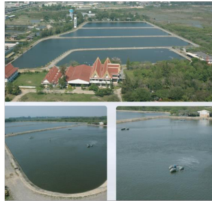
ระบบสระเติมอากาศ (AL)
