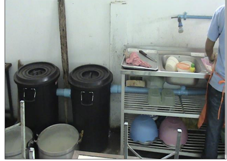
รูปที่ ๓.๑๐ ตำแหน่งการติดตั้งถังหรือบ่อดักไขมัน
